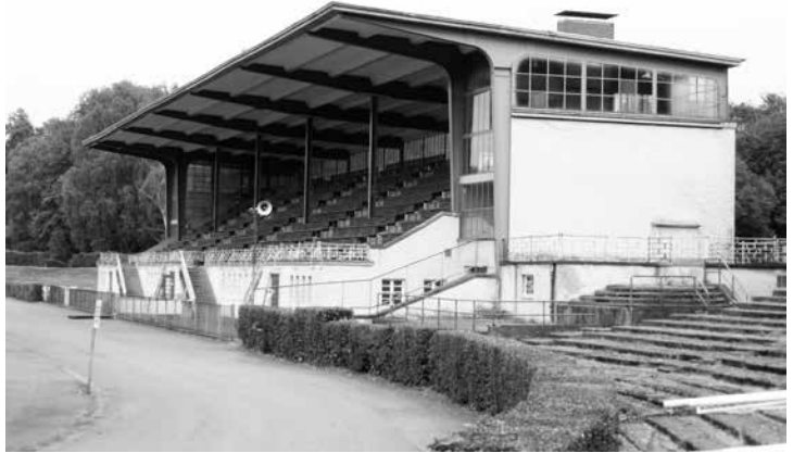
... und die Haupttribüne mit Umkleidekabinen und Sanitärräumen. Foto (2): Löhr
