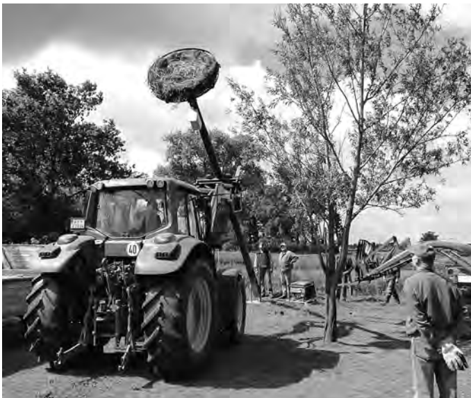
Der 5 Meter lange Mast mit der Nisthilfe wird aufgestellt.
