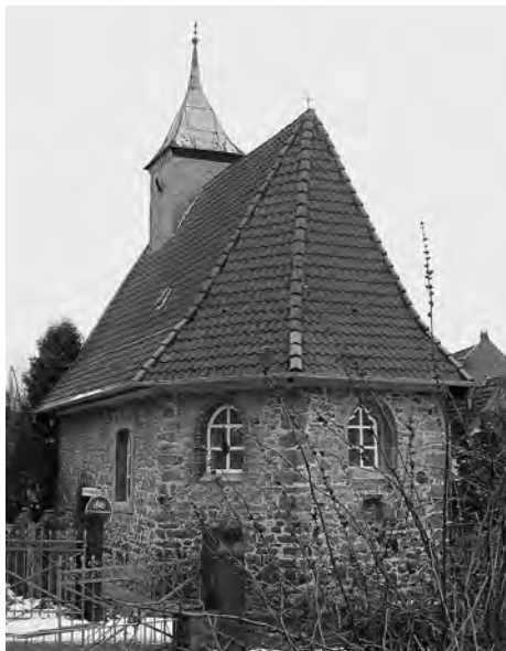
Die 1494 im heutigen Höver errichtete Kapelle war eine Wehrkirche mit 80 Zentimeter starken Mauern.
