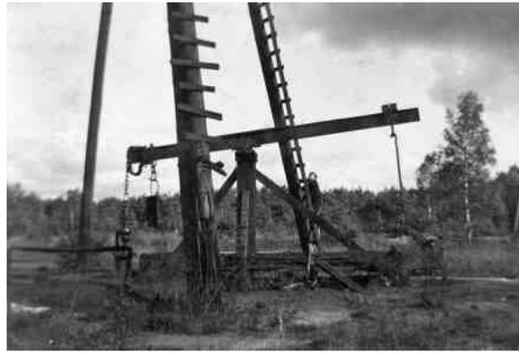
*Gestängetiefpumpe auf dem Kuhlenberg im Jahre 1950, dem Jahr der Stilllegung – Pumpenbock aus Holz, Balancier aus Stahl.*
