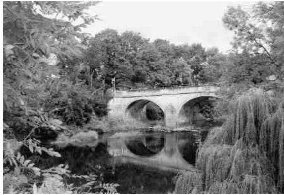
Architektonisches Kleinod in uriger Landschaft: Die historische Steinbrücke über der Leine bei Hofgut Calenberg (Foto: Strelow)
